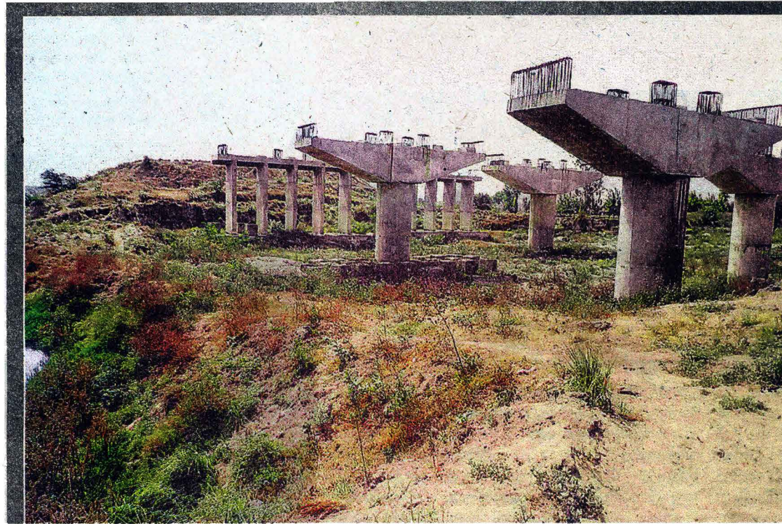
सोनीपत में जीटी रोड पर कुंडली मानेसर पलवल एक्सप्रेस वे का निर्माणाधीन फ्लाईओवर।
